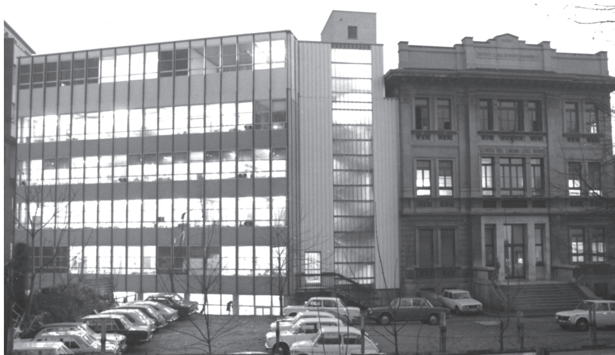
Figura 4 - Clinica del Lavoro: Edificio FEAL, ora Padiglione Vigliani (1963)
