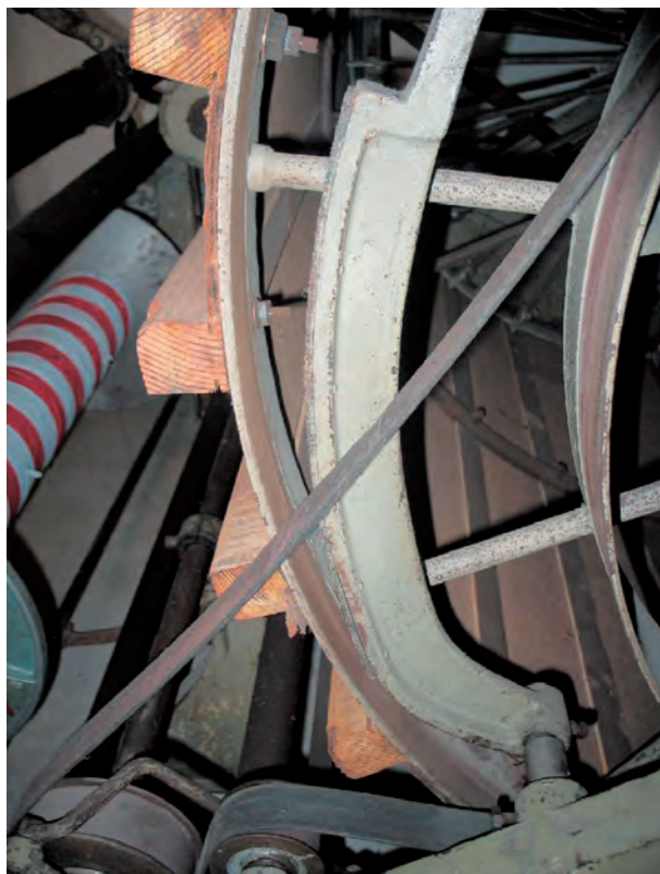
Figura 7 - Orditoio sezionale. Grande zoccolo frenante che rallenta o blocca la rotazione del tamburo: è visibile la guarnizione in amianto fissata mediante chiodatura
