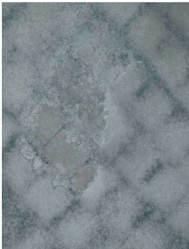
Figura 6 - Soffitto di stabilimento di filatura con amianto spruzzato evidentemente eroso da infiltrazioni di umidità
