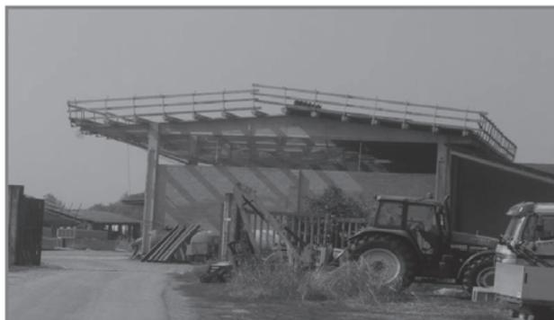
L'impresa per cui lavorava Roberto era una sub-appaltatrice dell'impresa affidataria per la realizzazione delle nuove coperture, ma in cantiere avevano operato altre imprese. Sul fabbricato in lavorazione erano state rimosse per metà della superficie le lastre in cemento amianto e il giorno dell'infortunio si stava procedendo alla realizzazione della nuova copertura.
