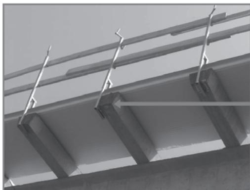
*Particolare del fissaggio inadeguato di un montante*
