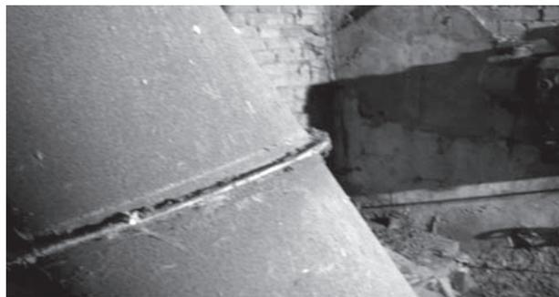
**Figura 5** - Guarnizioni in MCA delle tubazioni
