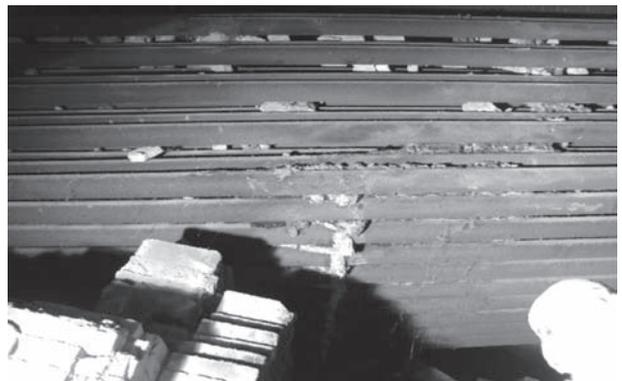
**Figura 3** - Materiale fibroso isolante che fuoriesce dai tubi dell'impianto di evaporazione
