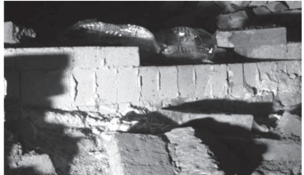
**Figura 2** - Particolare della muratura del forno con la malta costituita da cemento-amianto
