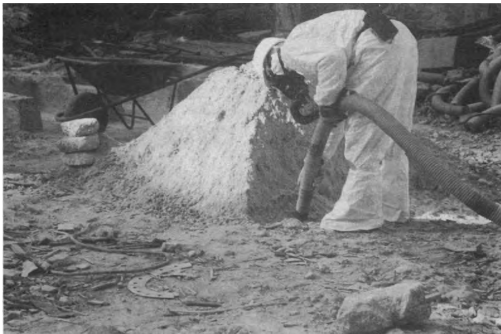
Fig. 1. Lo zuccherificio di Crevalcore: lavori di decontaminazione Da Acquafresca 4
